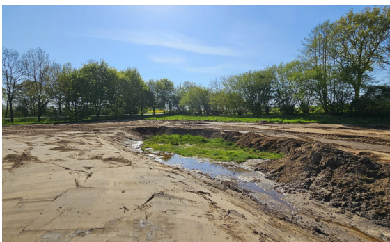
Baufortschritt Feuerwehrhaus Kochendorf
